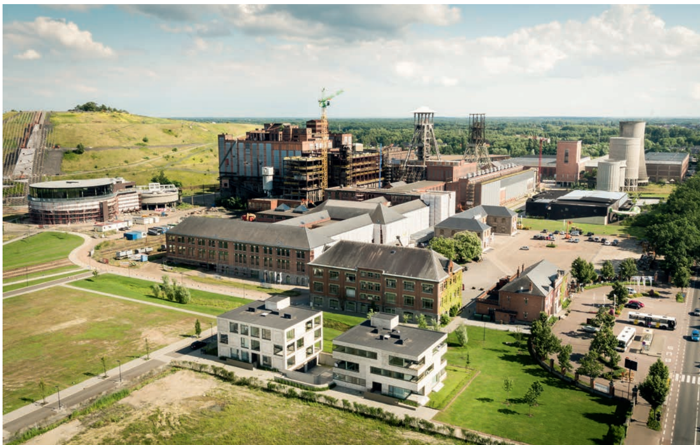
Alle industriële gebouwen werden bewaard: de machinezaal, de kolenwasserijen, de koeltorens, de badzalen met doucecabines en lockers.
